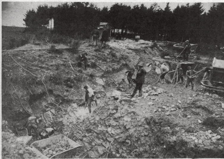
Die Quarzitlager bei Munshausen werden freigelegt.
