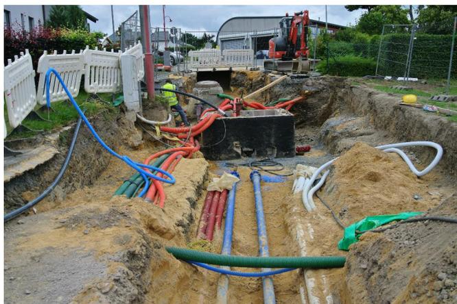
In Lellingen, Op de Leën, wurden sämtliche Infrastrukturen (Kanal, Wasserleitung, Strom, Post, Teleantenne) neu verlegt.
