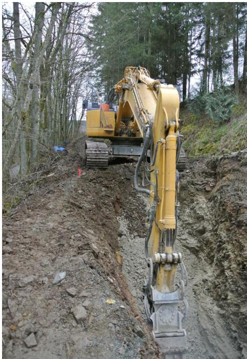
Bauarbeiten für die Kläranlage in Alscheid. Der erste Teil der Arbeiten: Die Rohre werden von der Kläranlage, die im kommenden Jahr gebaut wird, zur Clerve hin verlegt.
